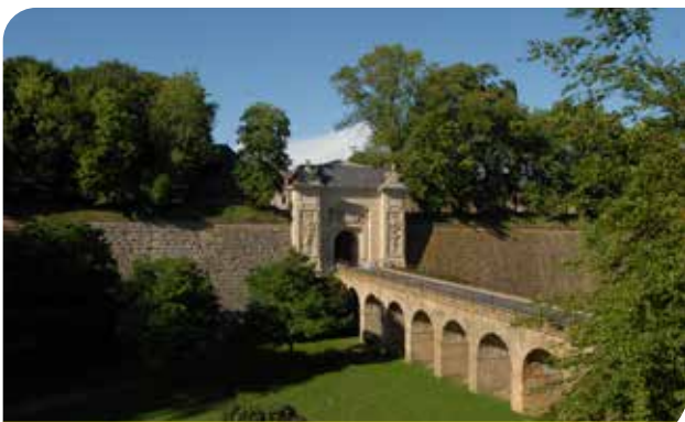
Ramparts and Porte de France, Longwy ©Ville de Longwy
